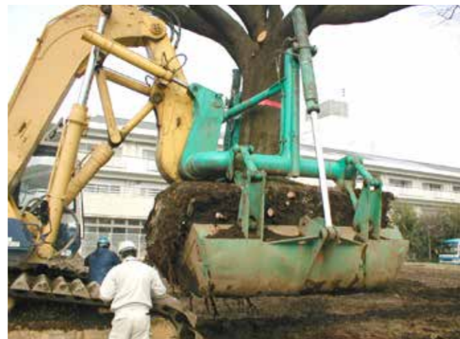
シンボルツリーの移設作業の様子
